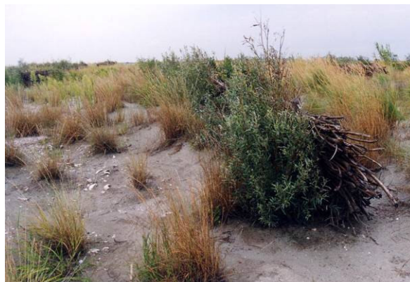
Foto 134 e Foto 135 Stabilizzazione di cordoni dunali mediante graticciate e trapianti di cespi di Ammophila arenaria e graticci con legno morto e vivo ( Salix alba ) (Località La Vallona – Po di Levante RO) (foto G. Sauli anni '80)
