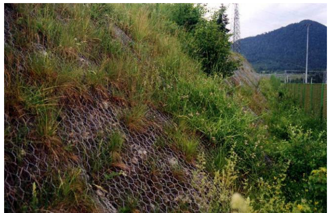
Foto 245 La stessa scarpata dopo qualche anno, con buona riuscita del verde, pure in assenza di riporto di terreno vegetale.
