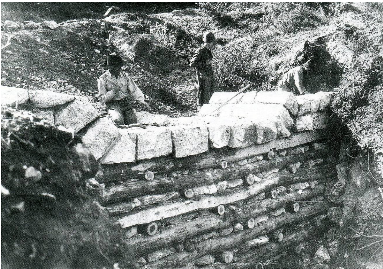
Fig 24 Briglia in legno e pietrame con gàveta in pietra da taglio, come da disegno riportato sopra (da Malpaga e Mussi, 2004)
