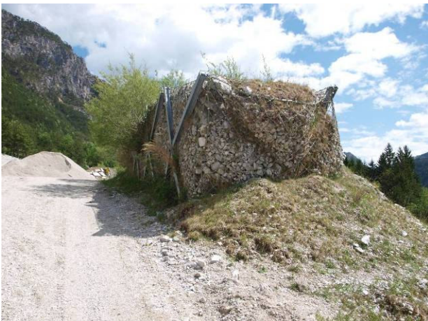
Foto 106 Valli paramassi con briglie ad ombrello doppie rinverdate con talee di salici (Foto G. Sauli maggio 2011)
