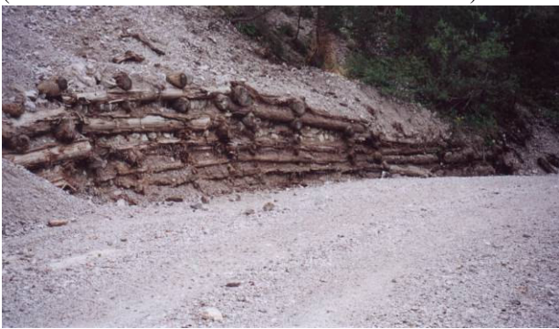
Foto 326 e Foto 327 Palificate ammalorate per cedimento della struttura lignea da rifare (Foto G. Sauli)
