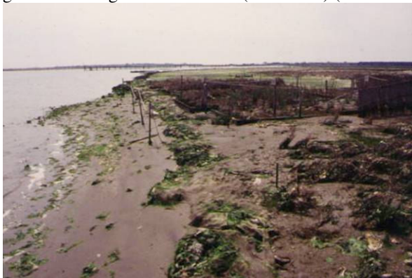
Foto 136 e Foto 137 Ricostruzione di isolotti con dragaggi a matrice sabbiosa con prove di messa a dimora di specie alofile (Laguna di Caleri Po di Levante RO) (foto G. Sauli anni '80)
