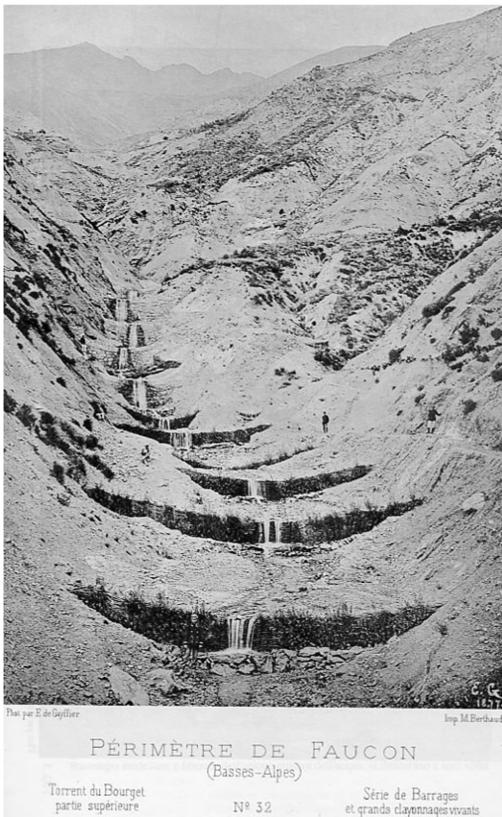
Fig. 18 Sistemazione con graticciate alte viventi di un tronco del Torrente Bourget in Francia disposte come soglie a valle di briglie in muratura. Anche qui le tipologie impiegate dipesero dalla funzione assegnata ai manufatti.
