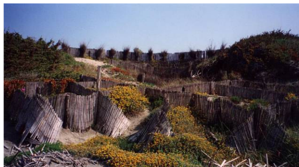
Foto 165 Dune costiere - Parco del Circeo, aprile 2003, resti delle graticciate utilizzate per intrappolare la sabbia e limitare l'erosione. Nella parte alta fascine morte di saggina (foto G. Sauli)
