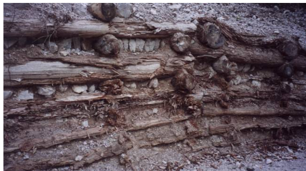
Foto 42 Particolare vecchie palificate in legname e pietrame in disfacimento (Valcanale UD – Foto G. Sauli)
