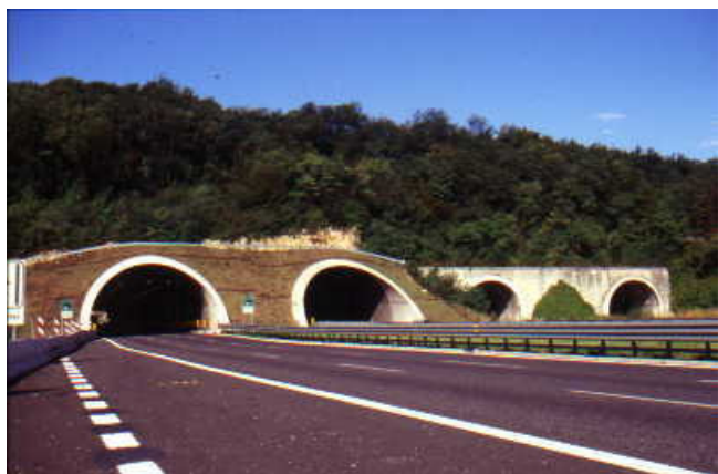
Foto 176 - a destra vecchio portale in cls, a sin nuova tipologia rivegetabile con semine e vimate. (Foto G. Sauli)
