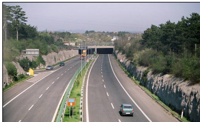
Foto 214 – Galleria artificiale rivegetata con funzioni di continuità faunistica (Grande Viabilità Triestina loc. Prosecco – Foto G. Sauli)
