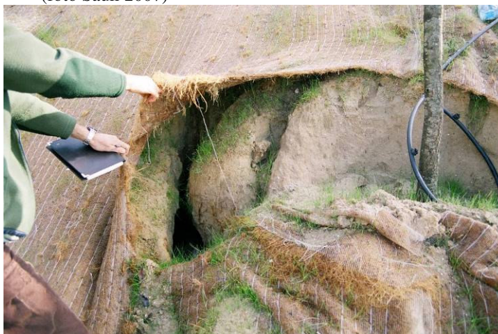
Foto 229 Uso di materassini in fibra di cocco su substrati ghiaiosi non sostituisce il terreno vegetale e impedisce lo sviluppo della vegetazione per eccesso di azione pacciamante (foto Sauli 2007)
