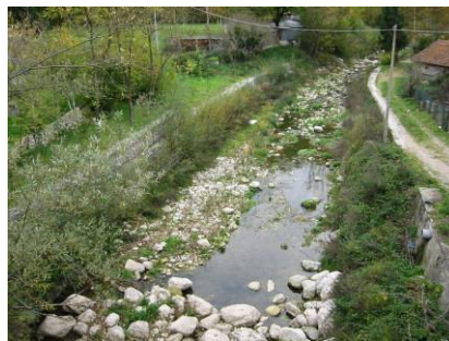
Foto 25, Foto 26, Foto 27 L'inserimento di talee nelle gabbionate è un elementare, ma indispensabile accorgimento per ricostituire la fascia ripariale dopo la distruzione. Foto Cornellini
