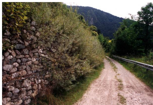
Foto 295 Gabbionate verdi di versante – Loc. Moggio (UD) (foto V. Zago)
