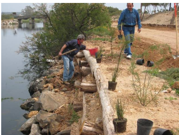
Foto 148 e Foto 149 Realizzazione di palificate vive spondali e trapianto di specie arbustive autoctone (foto P. Cornelini)
