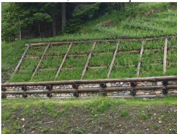
Foto 285 Mantellata con tronchi orizzontali disposti sotto quelli verticali e senza talee di salici. Alta Val Uque (Valcanale – UD) – Foto G. Sauli 5.6.2011
