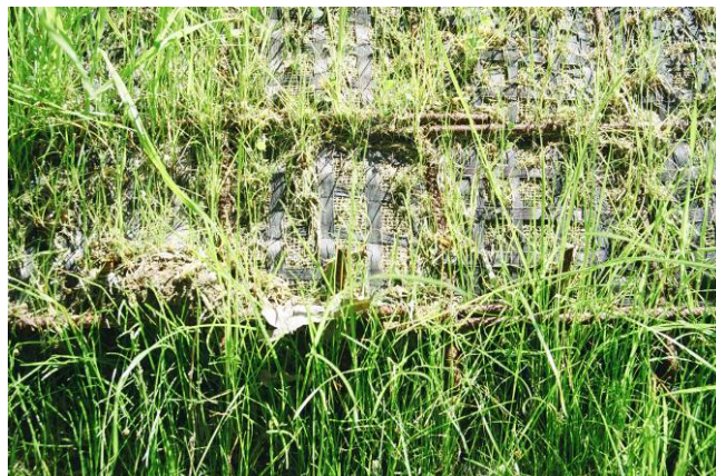
Foto 195 - Messa a dimora di talee di salice su TRV con griglie metalliche, reti sintetiche e stuoie nella sequenza dall'esterno verso l'interno (GVT - Foto G. Sauli 2009)
