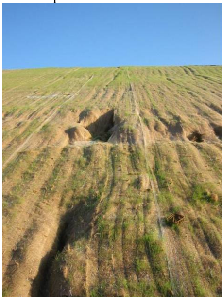
Foto 155 e Foto 156 Scarpate artificiali su terreni sabbiosi con evidenti fenomeni erosivi nonostante l'impiego di biostuoie inerbite (foto P. Cornellini)
