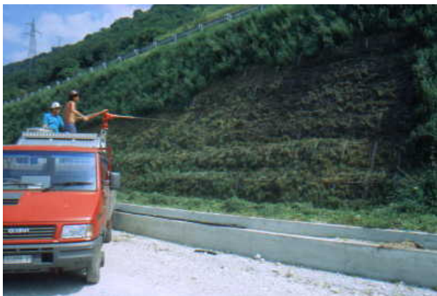
Foto 184 - Idrosemina di rincalzo su TRV (Autostrada V.Veneto - Pian di Vedoia – foto G. Sauli 1989)
