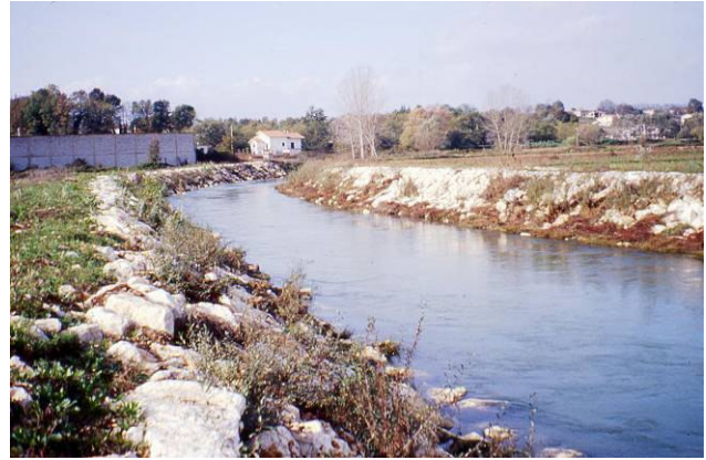
Foto 24 Il rivestimento spondale in massi costituisce una struttura permeabile, ma comporta l'eliminazione della vegetazione ripariale, che va ripristinata con l'inserimento di talee di specie igrofile. Foto Cornellini.
