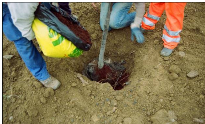
Foto 189 – Messa a dimora di albero in zolla con rincalzo di torba e terreno vegetale. (foto G. Sauli)
