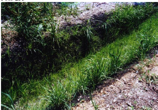
Foto 255 Fosso di guardia in geostuoia tridimensionale sintetica bitumata in opera e inerbita con funzione di infiltrazione (Ferrovia Pontebbana loc. S. Leopoldo – foto G. Sauli 2002)
