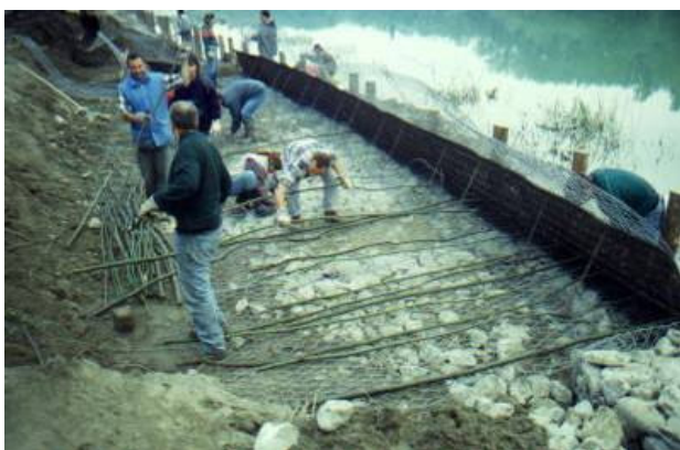
Foto 314 Efficace inserimento di talee di salice in profondità durante la costruzione di una terra rinforzata spondale
