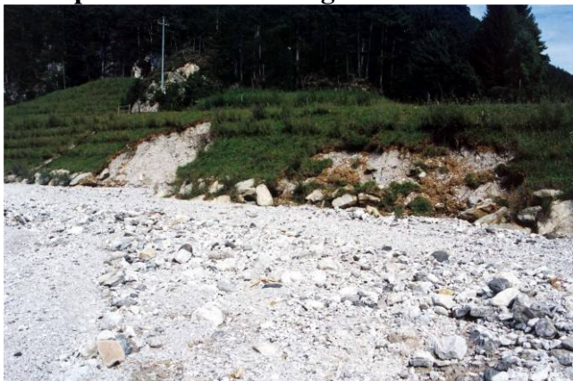
Foto 70 Cedimenti localizzati della scogliera a seguito dell'alluvione catastrofica del 29 agosto 2003
