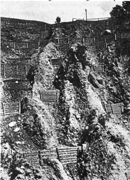
Fig. 23 Briglie in legname e pietrame costruite nei dintorni di Domodossola (da Wang, 1905).
