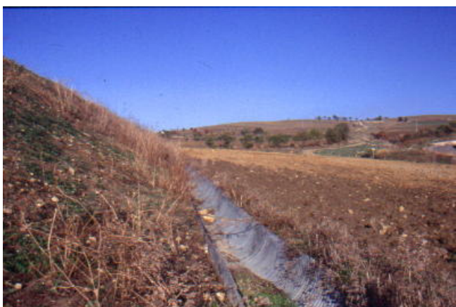
Foto 249 Canaletta in metallo con problemi di sifonamento (Foto G. Sauli)
