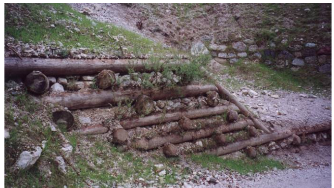
Foto 38 Sostegno di pista forestale su versante franoso a valle con terra rinforzata verde e a monte con palificata in legname e pietrame (foto G. Sauli)
