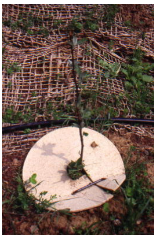
Foto 188 – Messa a dimora di arbusto con disco pacciamante e impianto di irrigazione a goccia (foto G. Sauli)
