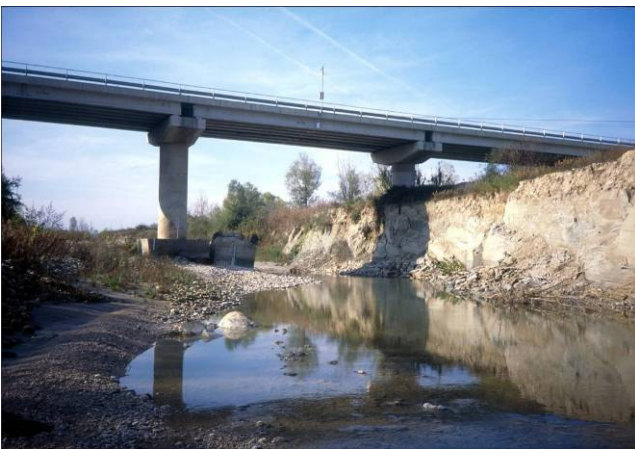
Foto 18 Incisione: scalzamento delle fondazioni di infrastrutture. F. Vomano (TE) Foto Ruggieri
