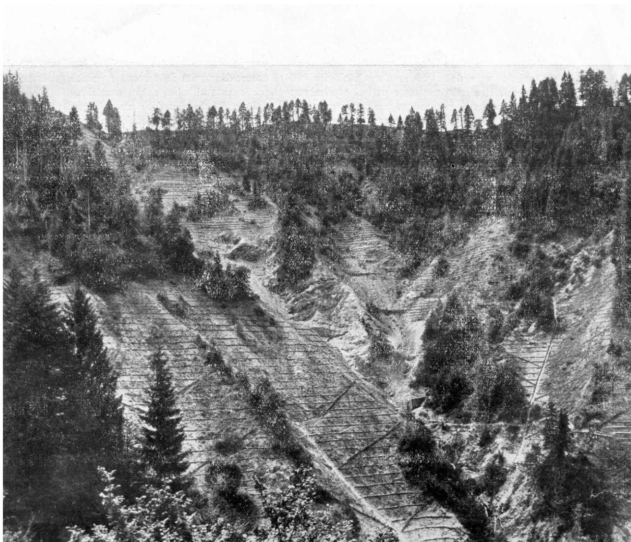
Fig. 37. Sistemazione idraulico-forestale con piccole briglie, graticciate e scoline selciate (da Mannozi-Torini, 1942a).
