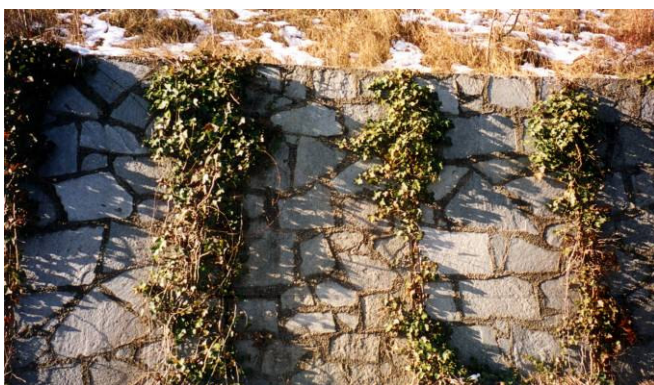
Foto 305 Muro con rampicanti, esempio di falsa ingegneria naturalistica
