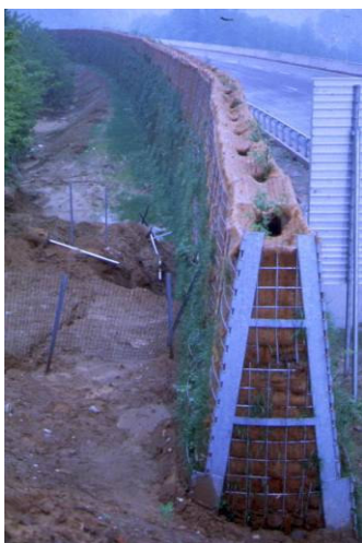
Foto 203 – Barriera antirumore vegetata ad arbusti autoctoni in terrapieno compresso in struttura metallica (Autostrada dei Trafori – Foto G. Sauli fine anni '80)
