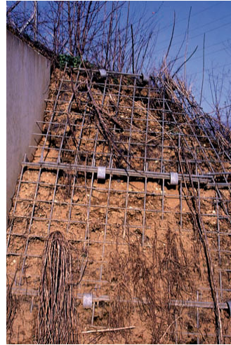
Foto 316 Terra rinforzata rinverdita (di versante), . Parziale svuotamento favorito da uno scarso attecchimento della componente vegetale (post operam) (Foto R.Ferrari). Da quaderno di cantiere:Terra rinforzata rinverdita di versante.
