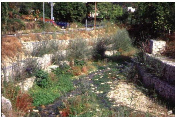
Foto 292 Gabbionate rinverdite con talee di salice disposte su file, nella prima maglia inferiore dei gabbioni, Rio Valleluce Cassino (FR) marzo 2000
