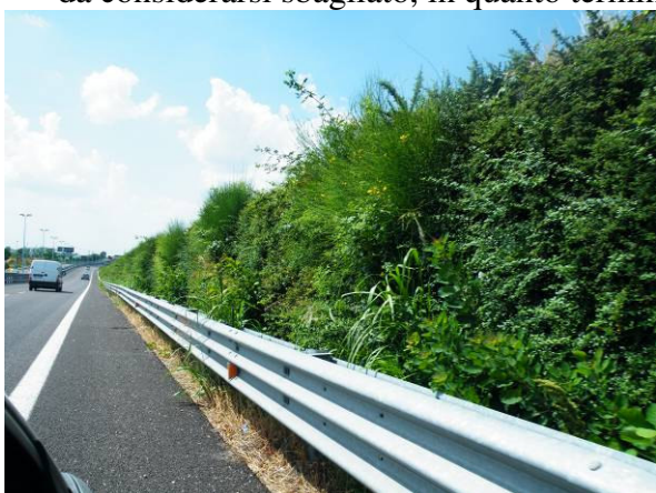
Foto 201 – Barriera antirumore in cls vegetata (Tangenziale di Mantova - Foto R. Santero)
