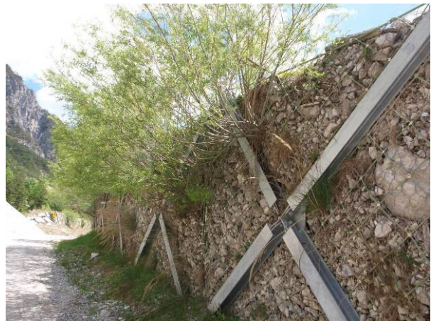
Foto 107 Buon sviluppo delle talee poste nella ghiaia di riempimento durante la costruzione (foto G. Sauli maggio 2011)
