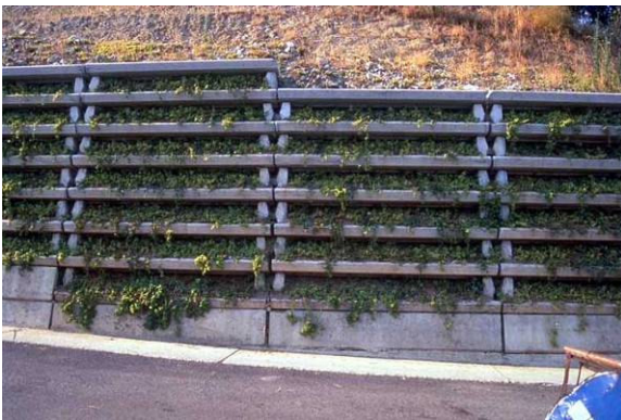
Foto 320 Muri cellulari con impiego di Mesembryanthemum quale esempio di falsa ingegneria naturalistica
