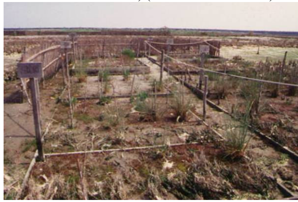
Foto 136 e Foto 137 Ricostruzione di isolotti con dragaggi a matrice sabbiosa con prove di messa a dimora di specie alofile (Laguna di Caleri Po di Levante RO) (foto G. Sauli anni '80)
