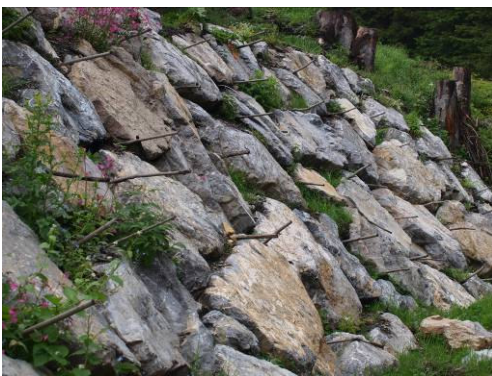
Foto 317 Mancato ricaccio delle talee di salice dopo un anno benché inserite in profondità durante la costruzione. Probabili cause: mancata potatura a 10-15 cm, massi troppo grandi e quindi mancata circolazione d'acqua. (Alta Val Uque – UD – foto G. Sauli giugno 2011)
