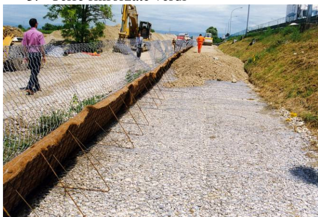
Foto 192 - TRV con rinforzi orizzontali in rete metallica (A4 Casello di Villesse – Foto R. Ferrari)
