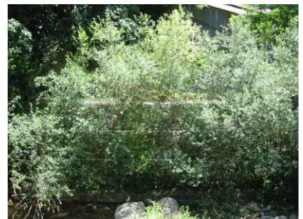
Foto 25, Foto 26, Foto 27 L'inserimento di talee nelle gabbionate è un elementare, ma indispensabile accorgimento per ricostituire la fascia ripariale dopo la distruzione. Foto Cornellini
