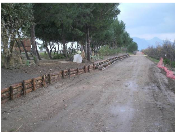
Foto 147 Palificate e palizzate di consolidamento lungo un'infrastruttura viaria (foto P. Cornelini)
