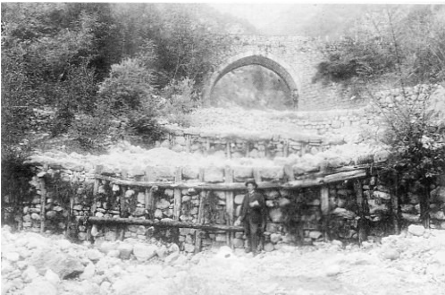
Fig. 22 A partire dal 1807, lungo il corso superiore del Torrente Magnone vennero realizzate numerose briglie «con telaio frontale in legname di castagno e riempimento di grossi blocchi a tergo» (da Malpaga e Mussi, 2004).
