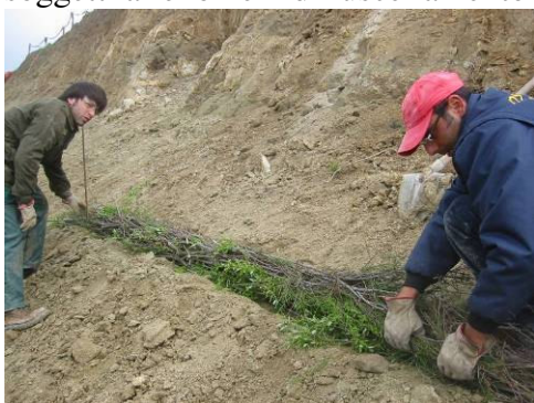
Foto 275 Posa su suoli sabbiosi di fascinata viva di tamerici quale intervento stabilizzante La Leprignana (Foto C. Cornellini 2007)
