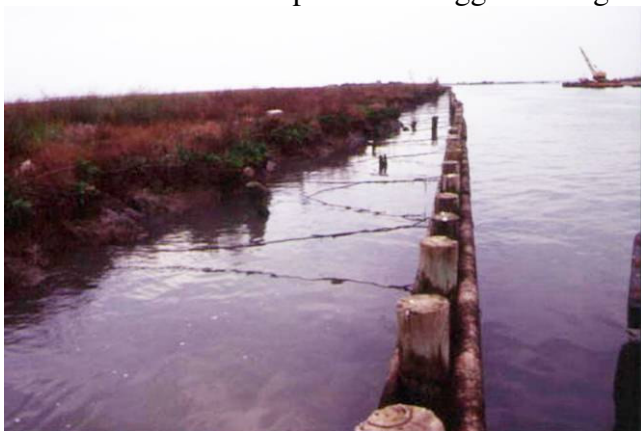
Foto 127 e Foto 128 Prove, scarsamente efficaci, di consolidamento in tronchi e tavole tirantati, con messa a dimora di tamerici per lo stoccaggio di fanghi di drenaggio di canali lagunari (Laguna di Marano UD) (foto G. Sauli anni '80)
