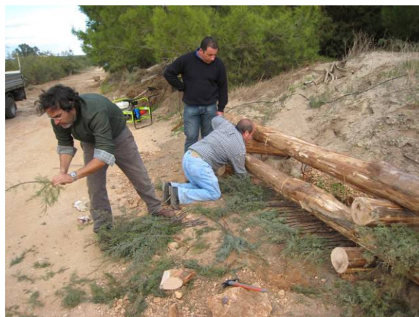
Foto 146 Realizzazione di una palificata viva con inserimento di talee di tamerice (foto P. Cornelini)
