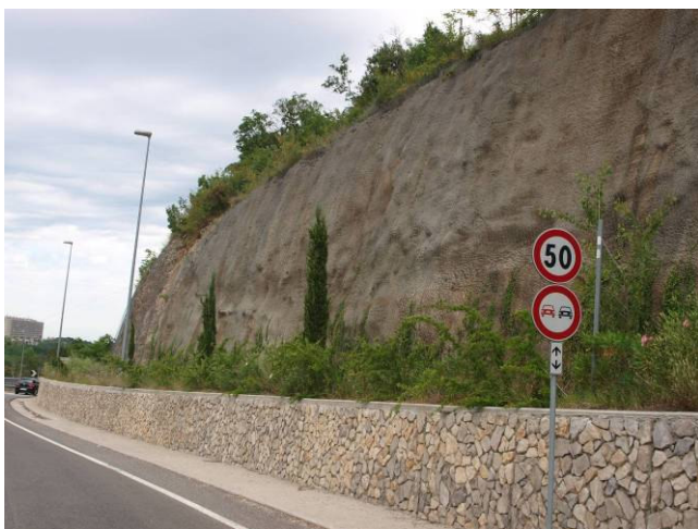
Foto 233 Esempio negativo di rinverdimento di scarpata in roccia con spritz beton, edera rampicante ed esotiche arboree ed arbustive (Cipresso, Piracanta, Oleandro) (Foto G. Sauli 2011)
