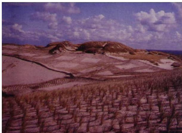
Foto 115 Stabilizzazione di dune sulle coste del mare del nord, con messa a dimora a quadroni di ammobila (foto Lux anni '70)
