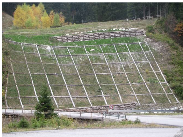
Foto 34 Esempio di interventi su versanti con tecniche a basso impatto (mantellate, biostuoie e palificate con pietrame e legname), ma senza abbinamento con specie arbustive (Loc. Fleons –UD Foto Gollino 2009)
