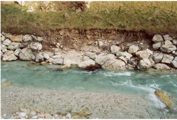
Foto 318 Scogliere con massi legati e talee di salice. Cedimenti localizzati, per mancanza di piloti di fissaggio, a seguito dell'evento alluvionale del 2003 (T. Slizza – Foto G. Sauli)
