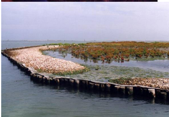
Foto 132 e Foto 133 Ricostruzione di barene con fanghi di dragaggio; contenimento con pali e geotessuti (Località La Vallona – Po di Levante RO) (foto G. Sauli anni '80)
