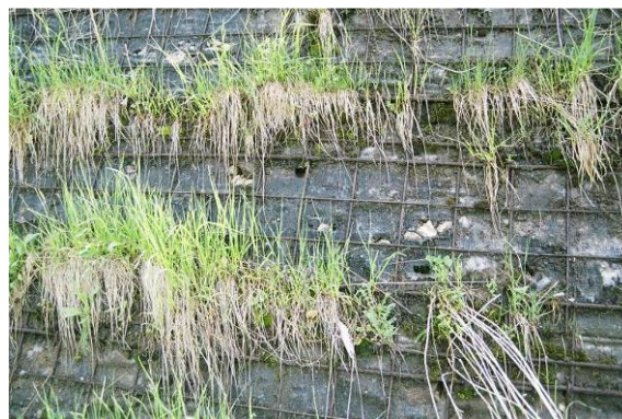
Foto 308 TRV strada per Piancavallo (PN) anni '80. Dopo oltre ventanni i feltri non hanno consentito lo sviluppo dei cotici erbosi (presenti radi cespi tra uno strato e l'altro) sono in disfacimento (probabile demolizione per effetto fotochimico) e lasciano intravedere l'inerte sassoso retrostante (assenza totale di terreno vegetale) foto G. Sauli 2006
