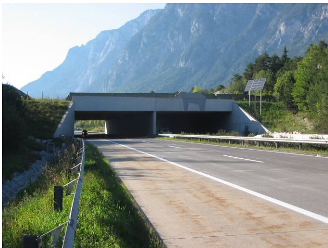
Foto 213 – Sovrappasso per orsi (Autostrada A2 presso Arnoldstein - Austria – Foto G. Sauli)
