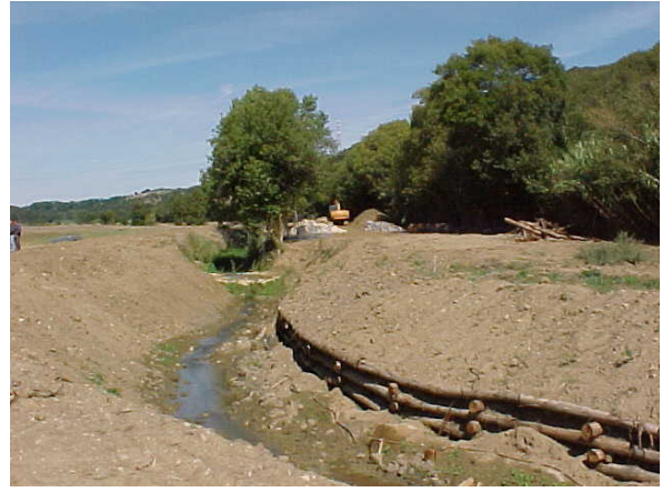
Foto 28 e Foto 29 Due esempi da non seguire: a sinistra una difesa spondale priva di piante, con strutture simmetriche e stessa sezione tipo ripetuta per lunghi tratti che non tiene conto della variabilità morfologica (erosione in zona concava deposito in zona convessa) ed ecologica del corso d'acqua; a destra strutture prive di piante, spacciate per ingegneria naturalistica. Foto Cornellini
