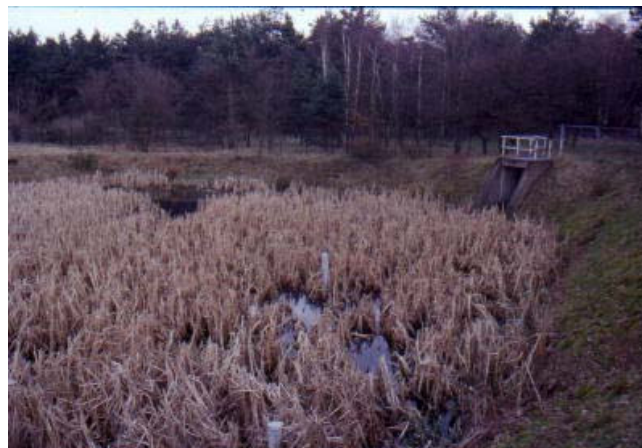
Foto 210 – Vasca di prima pioggia con funzione di habitat umido e fitodepurazione (Germania – Foto G. Sauli)
