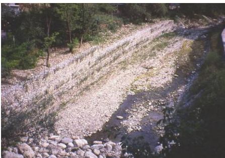
Foto 25, Foto 26, Foto 27 L'inserimento di talee nelle gabbionate è un elementare, ma indispensabile accorgimento per ricostituire la fascia ripariale dopo la distruzione. Foto Cornellini
