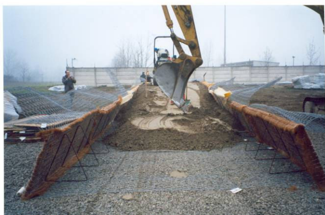
Foto 205 – Barriera antisvicio in doppia terra rinforzata verde in fase di costruzione (Foto F. Ferraiolo)
