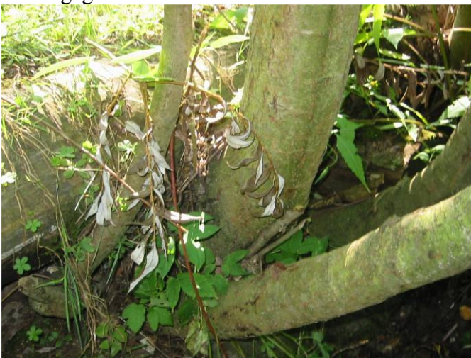
Foto 33 Nella palificata viva spondale dopo qualche anno le talee di salice potranno sostituire i tronchi in decomposizione. Foto Cornellini
