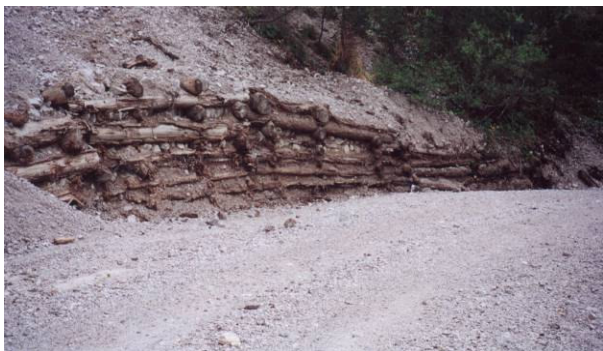
Foto 41 Vecchie palificate in legname e pietrame in disfacimento (Valcanale UD – Foto G. Sauli)
