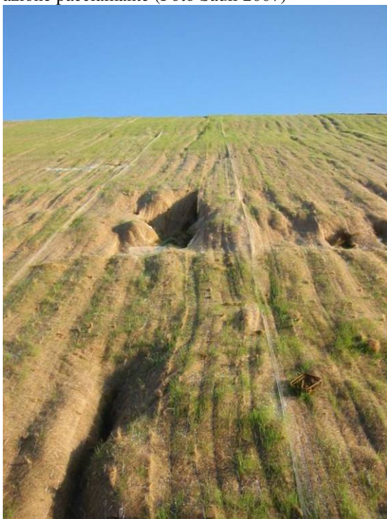
Foto 230 e Foto 231 Uso improprio di stuoie in fibra di cocco su scarpate in sabbia con pendenza limite.
