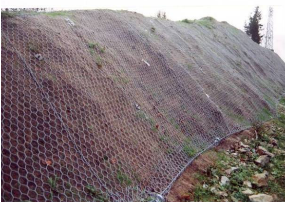
Foto 244 Rivestimento in rete metallica e stuoia organica di scarpate in trincea in roccia (Nuova stazione di Bosco verde (Tarvisio –UD – foto Sauli)
