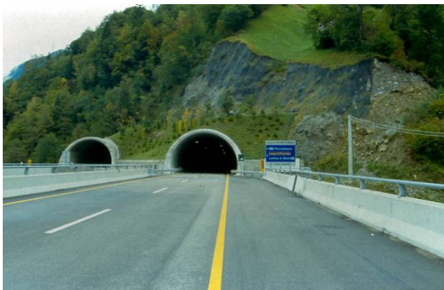
Foto 178 - Prolungamenti in galleria artificiale con rilevati rivegetati ad alberi locali (Autostrada A 23 galleria di Pontebba – Foto G. Sauli ottobre 1987)
