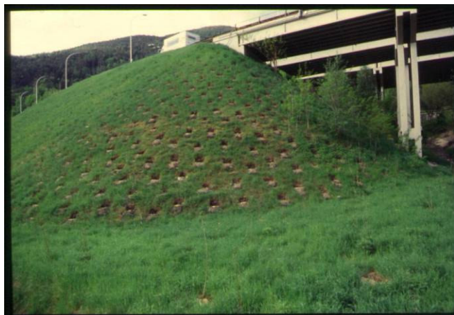
Foto 174 -Rivegetazione ad arbusti di un rilevato spalla di viadotto (Autobrennero – Bolzano nord – Foto G. Sauli)
