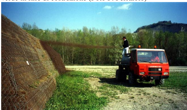
Foto 205 – Barriera antisvicio in doppia terra rinforzata verde in fase di costruzione (Foto F. Ferraiolo)
