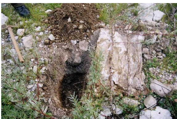
Foto 266 Abbinamento di non tessuto a supporto delle talee in cordonate vive impedisce lo sviluppo verticale delle radici dei salici vanificando l'effetto funzionale stabilizzante (Val di Gleris –UD foto Sauli, agosto 2006)
