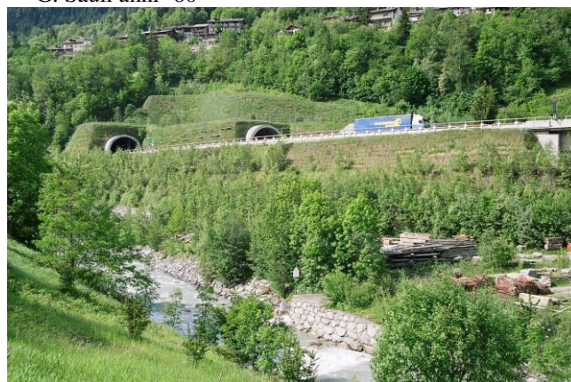
Foto 312 idem dopo 18 anni. Si noti la crescita rigogliosa di arbusti ed alti arbusti che maschera completamente la struttura e contribuisce alla finzione stabilizzante del cuneo frontale (Foto G. Sauli 2006)
