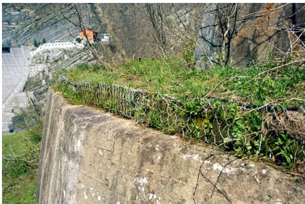
Foto 304 Rivestimento di rocce arenacee con materassi verdi, Diga di Ridracoli, (FO), 2005, Foto: G. Sauli
