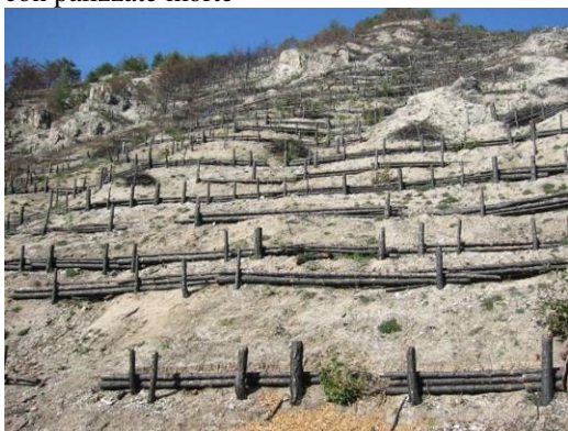
Foto 111 Pizzoli (AQ) 2002 foto Sacchetti. Particolare sistemazione con palizzate morte
