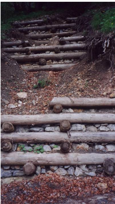
Foto 39 e Foto 40 Briglie in legname e pietrame analoghe strutture realizzate senza e con inserimento di talee di salice.
