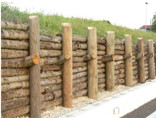
Foto 43 Palizzata morta di contenimento di scarpata (Irpinia –Foto G. Sauli 2010)
