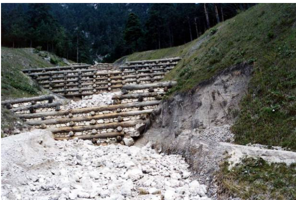
Foto 325 Cedimenti della sponda-versante e imposta della briglia a seguito di evento alluvionale di debris-flow (Rio Anonimo – Valcanale – foto G. Sauli 2003)
