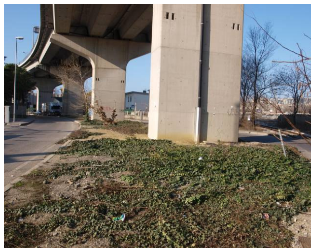
Foto 198 – Impiego delle acque di sgrondo mediante tubi diffusori per rivegetazione ad edera (Grande Viabilità di Trieste – Via Caboto) gennaio 2010. Foto G. Suli
