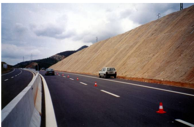
Foto 187 - Reti metalliche e stuoie organiche su scarpate in scavo in condizioni di forte aridità non sempre producono rivegetazione, pur mantenendo la funzione di stabilizzazione. (Sardegna SS 195 Pula – Foto G. Sauli fine anni '80)
