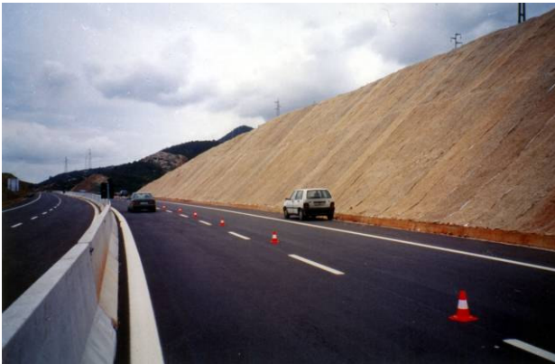
Foto 243 Reti metalliche e stuoie organiche su scarpate in scavo in condizioni di forte aridità (senza riporto di suolo) non sempre producono rivegetazione, pur mantenendo la funzione di stabilizzazione. (Sardegna SS 195 Pula – Foto G. Sauli fine anni '80)
