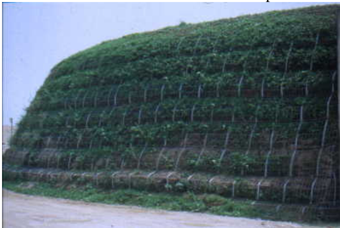
Foto 313 Mancata rullatura dell'inerte che produce nel breve importanti deformazioni della struttura Foto G. Sauli 1988
