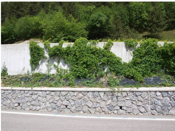
Foto 106 Valli paramassi con briglie ad ombrello doppie rinverdate con talee di salici (Foto G. Sauli maggio 2011)
