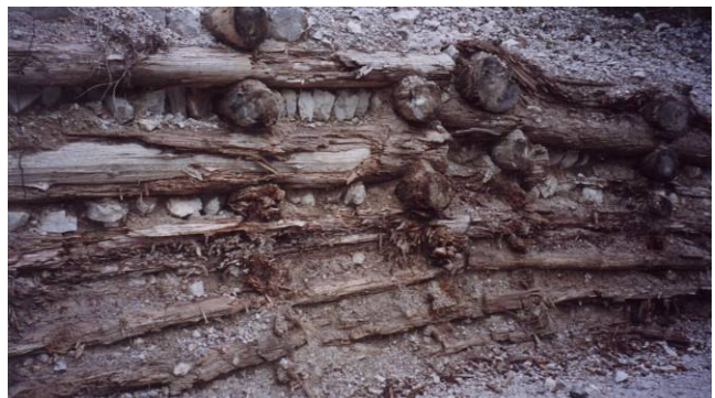
Foto 326 e Foto 327 Palificate ammalorate per cedimento della struttura lignea da rifare (Foto G. Sauli)
