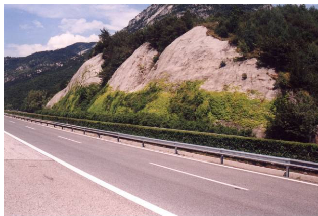
Foto 234 Rivestimento di scarpata in roccia con spritz beton e interventi successivi di mascheramento con rampicanti (esempio di falsa ingegneria naturalistica) (foto G. Sauli 2003).
