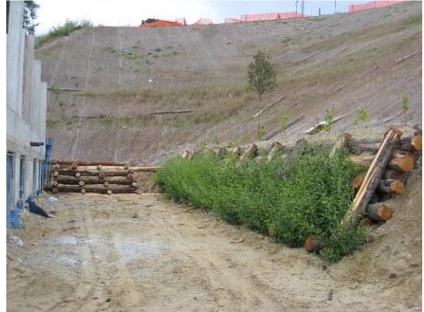
Foto 160 e Foto 161 Realizzazione di palizzate in tronchi orizzontali, palificate vive con arbusti mediterranei, al piede delle scarpate attigue alle residenze (foto P. Cornellini)
