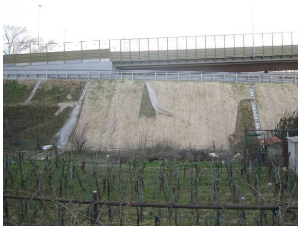
Foto 226 Insufficiente picchettaggio e conseguente distacco prima che si sviluppi il cotico erboso
