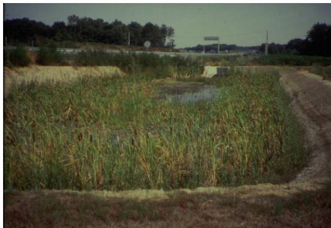
Foto 209 – Vasca di prima pioggia con funzione di fitodepurazione (Francia – Foto P. Cornellini)
