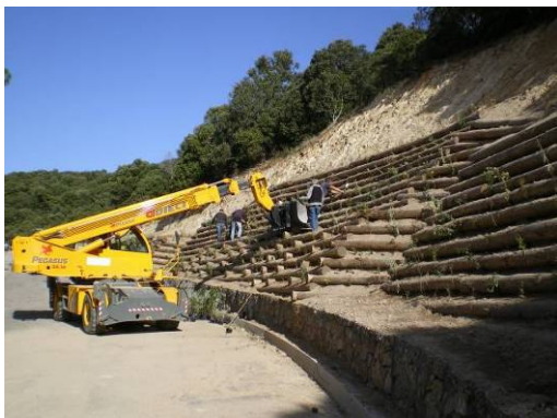
Foto 282 grate vive su palificate in costruzione, Nuoro novembre 2009, Foto P. Cornellini
