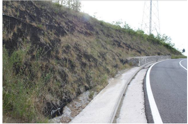
Foto 242 Rivestimento di scarpate in roccia arenacea con geocomposito in rete metallica e stuoia sintetica tridimensionale. L'assenza di terreno vegetale limita fortemente la crescita del cotico erboso lasciando in vista la stuoia sintetica (GVT – Foto Zago 2011)
