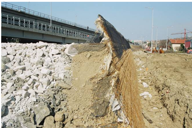
Foto 194 - TRV con armatura orizzontale in reti sintetiche e casseri esterni in griglie metalliche, reti sintetiche e stuoie organiche. Si noti la terra vegetale addossata alle stuoie e reti esterne (GVT loc. Domio – Foto G. Sauli 2008)
