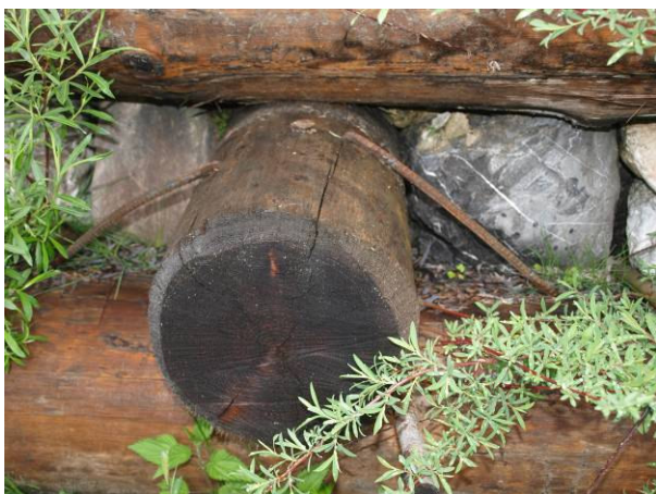
Foto 290 Particolare fissaggio temporaneo tronchi con cambre poi sostituito con chiodature in tondino d'armatura (visibile la testa nella foto) – Foto G. Sauli giugno 2011
