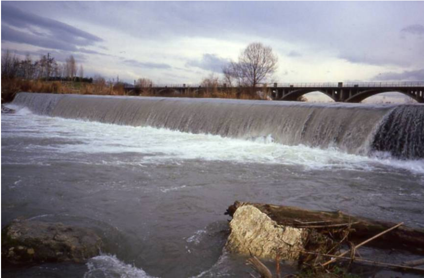
Foto 20 Controbriglia a difesa di una infrastruttura. F. Vomano (TE) Foto Ruggieri
