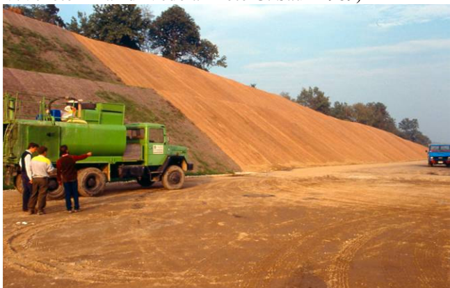
Foto 185 - Stuoie in cocco su scarpate in scavo in litologie sabbiose non sempre hanno assolto alla funzione di stabilizzazione essendo dei provvedimenti antierosivi (Autostrada dei trafori – ottobre 1988 – Foto G. Sauli)
