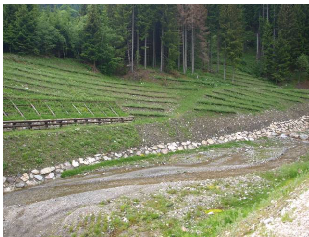
Foto 35 Sistemazione di versante franoso e sponda torrente con tecniche miste: scogliera, mantellate e gradonate vive. Alta Val Uque (Valcanale – UD) – Foto G. Sauli 5.6.2011
