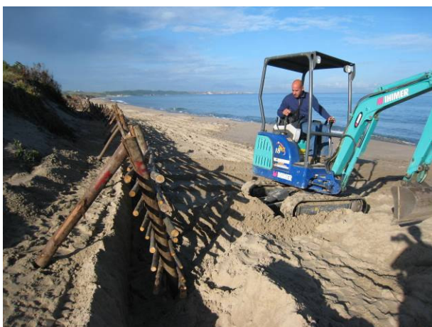
Foto 151 Realizzazione delle graticciate (foto P. Cornellini)
