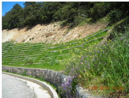
Foto 283 grate vive su palificate in costruzione, Nuoro maggio 2010, Foto P. Cornellini
