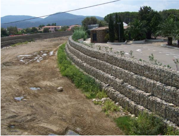
Foto 28 e Foto 29 Due esempi da non seguire: a sinistra una difesa spondale priva di piante, con strutture simmetriche e stessa sezione tipo ripetuta per lunghi tratti che non tiene conto della variabilità morfologica (erosione in zona concava deposito in zona convessa) ed ecologica del corso d'acqua; a destra strutture prive di piante, spacciate per ingegneria naturalistica. Foto Cornellini
