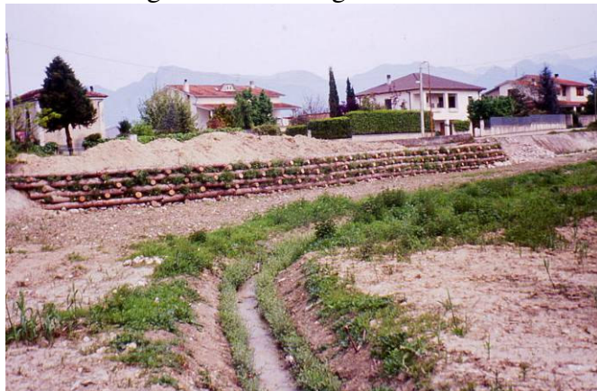
Foto 11 Realizzazione di savanella di magra per garantire una portata minima nella stagione secca. Foto Cornellini
