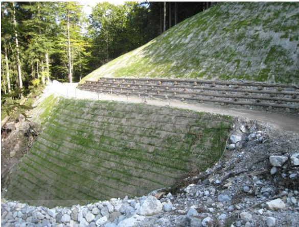
Foto 38 Sostegno di pista forestale su versante franoso a valle con terra rinforzata verde e a monte con palificata in legname e pietrame (foto G. Sauli)
