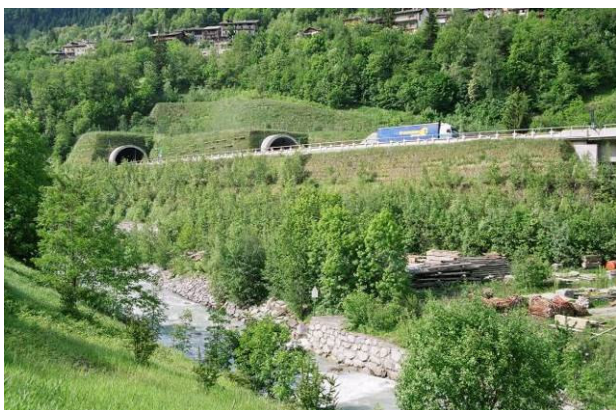
Foto 328 Esempio di terra rinforzata verde con massiccio sviluppo di vegetazione arbustiva senza necessità di manutenzione fatto salvo lo sgombero funzionale dei primi 2 metri dalla carreggiata
