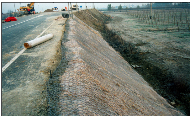
Foto 333 Rivestimento vegetativo in rete metallica e stuoie organiche con semine e messa a dimora di talee di salice su rilevato in argille stabilizzate a calce (SP 56 S. Donà VE – Foto G. Sauli 2004)
