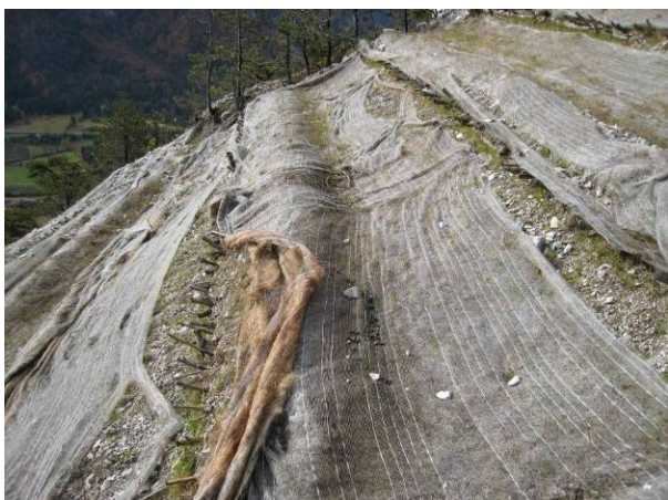
Foto 228 Uso di materassini in fibra di cocco su substrati ghiaiosi non sostituisce il terreno vegetale e impedisce lo sviluppo della vegetazione per eccesso di azione pacciamante (Foto Sauli 2007)
