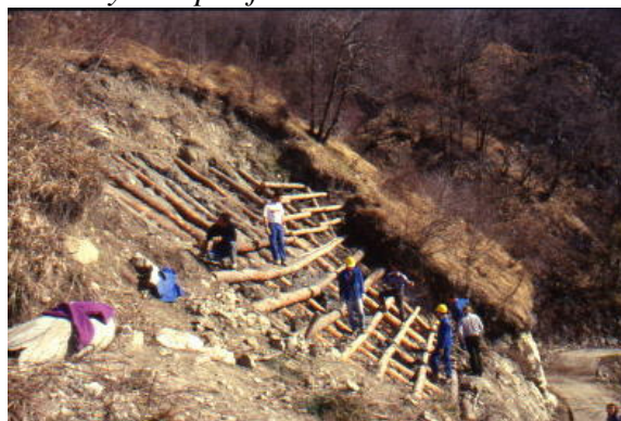
Foto 278 Durante il cantiere si noti la doppia fila di tronchi verticali (7 + 7 m) e la disposizione in aggetto dei tronchi orizzontali che diventeranno sostegno delle ramaglie e della terra ricaricata con diminuzione di pendenza per ogni singola nicchia (Montenars UD foto G. Sauli 1996)
