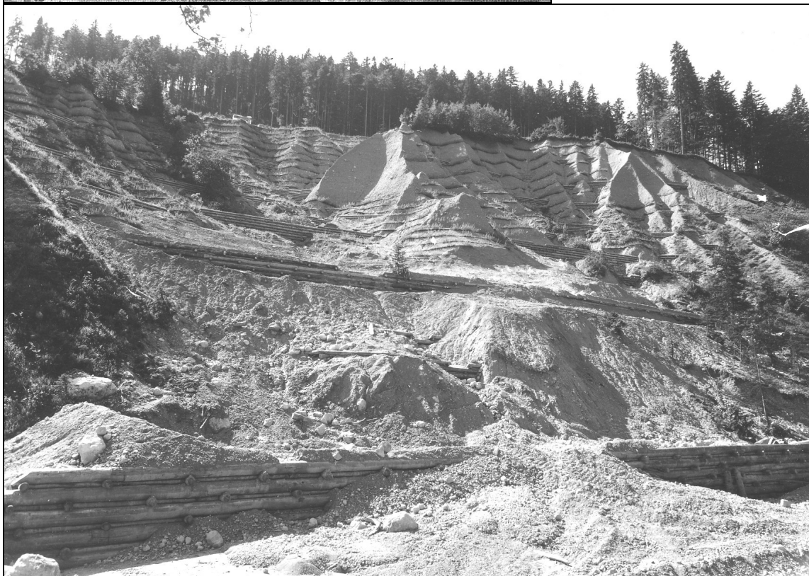
Fig.44. La palificata spondale costruita sulla colmata della briglia della figura 42, in d.i., dà sostegno alla sovrastante pendice, larga 100 metri, stabilizzata con una palificata intermedia, cordonate viventi, e briglie in pietrame e legname (foto Puglisi, 8 agosto 1970).
