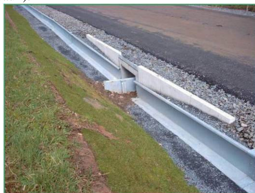
Foto 224 - Strutture metalliche di svio per anfibi collegate con diaframmi direzionali e sottopassi (Germania). Foto G. Sauli
