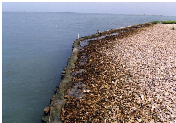
Foto 132 e Foto 133 Ricostruzione di barene con fanghi di dragaggio; contenimento con pali e geotessuti (Località La Vallona – Po di Levante RO) (foto G. Sauli anni '80)
