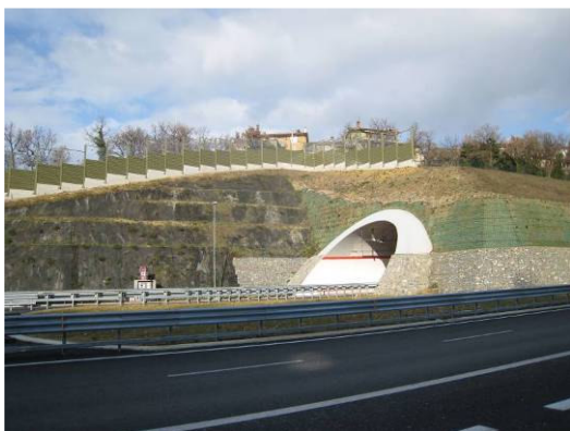
Foto 307 Impiego di feltri non tessuto come antierosivi impediscono lo sviluppo dei cotici erbosi (il colore verde del feltro evidenzia ulteriormente tale effetto negativo) Foto G. Sauli
