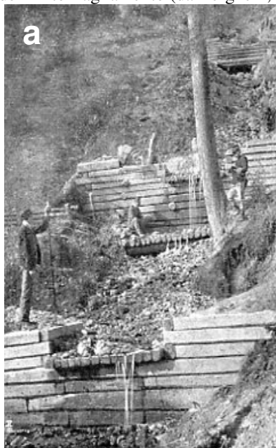
Fig. 14 In a sistemazione con briglie in legname costruite utilizzando assortimenti a sezione rettangolare (da Di Tella, 1912); in b stesso tipo di opera costruito con tronchi. Da notare la disposizione dei pali a valle dell'opera (da Dip.to Agricoltura degli Stati Uniti, in FAO, 1980).
