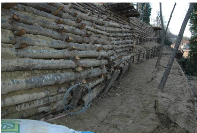
Foto 113 Palificata morta con evidenti cedimenti, Teramo - Foto Crocetti
