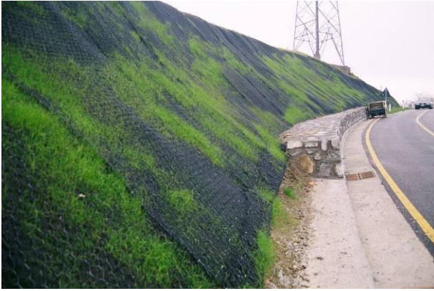
Foto 241 Rivestimento di scarpate in roccia arenacea con geocomposito in rete metallica e stuoia sintetica tridimensionale. L'assenza di terreno vegetale limita fortemente la crescita del cotico erboso lasciando in vista la stuoia sintetica (GVT – Foto Sauli 2007)
