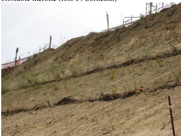
Foto 155 e Foto 156 Scarpate artificiali su terreni sabbiosi con evidenti fenomeni erosivi nonostante l'impiego di biostuoie inerbite (foto P. Cornellini)
