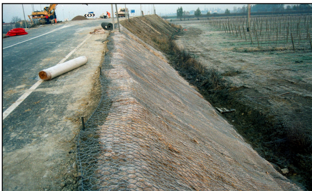
Foto 246 Rivestimento vegetativo con reti e biostuoie su rilevato in argille consolidate a calce (S. Donà di Piave – VE. Foto G. Sauli nov. 2004)
