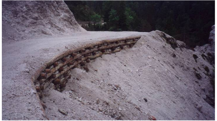
Foto 37 Palificata in legname e pietrame a sostegno di versante franoso a valle di pista forestale (foto G. Sauli)
