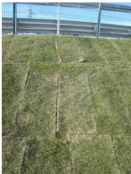
Foto 248 Rivestimento di scarpata con prato in rotolo con problemi iniziali di possibili scollature (G. Sauli 2008)
