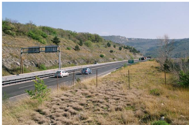
Foto 186 - Scarpate in rocce marnoso-arenacee rivestite con sola rete metallica. Lo sviluppo spontaneo della vegetazione è legato alla presenza di piccole berme su cui si è accumulato materiale terroso fine. (GVT svincolo Grandi motori – TS – Foto G. Sauli 2010).
