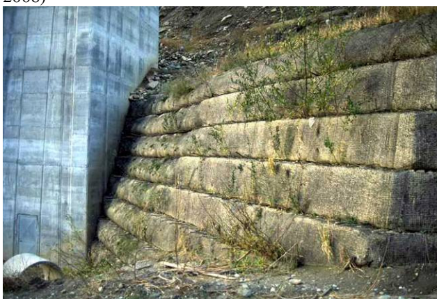
Foto 196 - TRV in reti sintetiche con talee di salice (autostrada del Frejus anni '80 - Foto P. Fantini)
