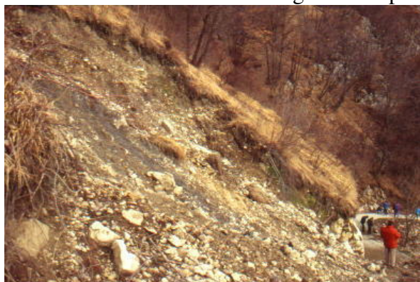
Foto 277 ante operam con evidente fenomeno franoso irreversibile aggravato da venute d'acqua nella parte superiore (Montenars UD foto G. Sauli 1996)
