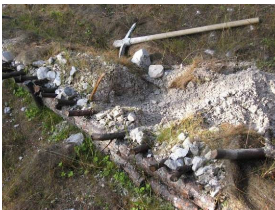
Foto 264 Insufficiente ricopertura con inerte delle talee produce essiccamento delle stesse alla prima stagione arida successiva alla messa a dimora
