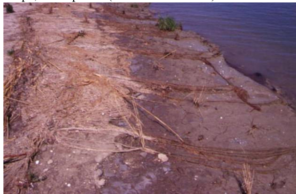
Foto 121 Totale inefficacia dell'impiego di stuoie di juta quale antiersivo spondale (Foto G. Sauli 1996)
