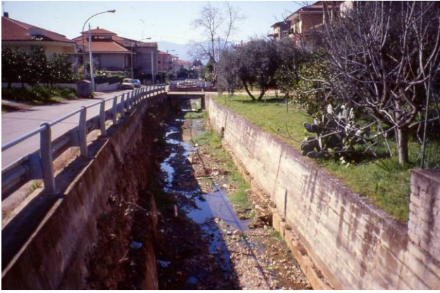
Foto 23 Alveo completamente artificiale con interruzione di ogni rapporto con la falda e l'ambiente circostante e, quindi della connettività trasversale e verticale. Foto Cornellini.
