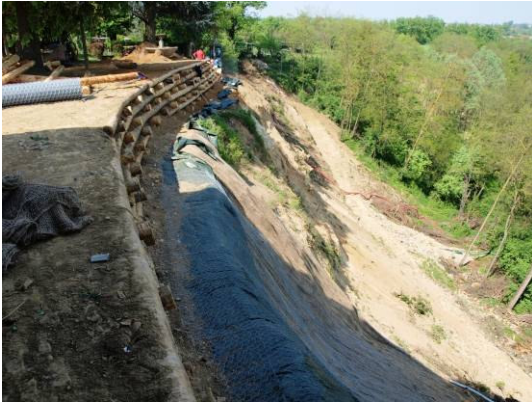
Foto 36 Sistemazione di versante franoso con palificata di corona e reti di juta e metallica, con telo impermeabile che risvolta sotto il tubo dreno e protegge il colmo del versante dall'infiltrazione delle acque meteoriche (Revignano d'Asti sin. idrografica T. Borbore – foto V. Fiore)
