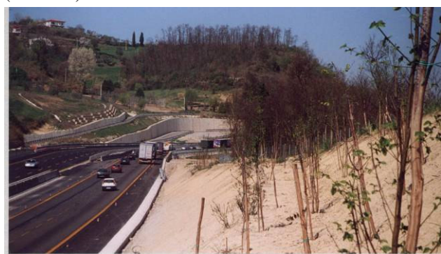
Foto 173 - Autostrada Fiano –Orte – Scarpate in trincea in argilla minerale – Piantazione di arbusti ed alberi (Foto G. Sauli 1998)
