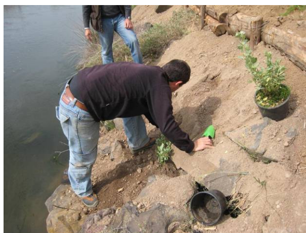
Foto 148 e Foto 149 Realizzazione di palificate vive spondali e trapianto di specie arbustive autoctone (foto P. Cornelini)
