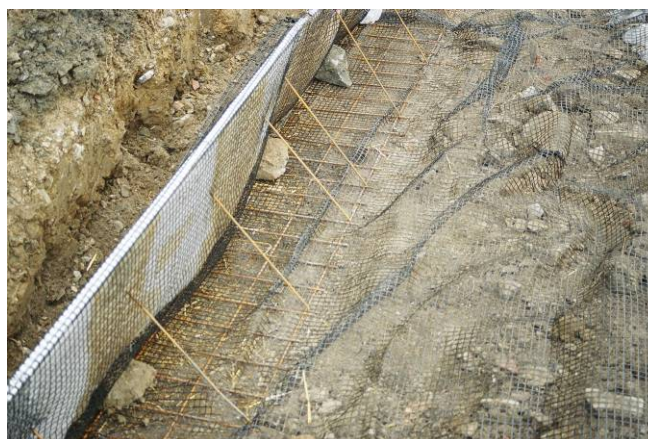
Foto 193 - TRV con armatura orizzontale in reti sintetiche (GVT loc. Domio – Foto G. Sauli 2008)
