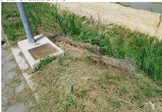
Foto 335 Idem conseguenza dell'uso della barra rotante sulle reti del rivestimento vegetativo ( Foto G. Sauli 2006)
