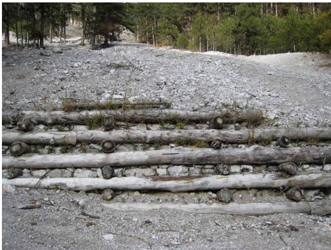
Foto 287– La palificata in legname e pietrame va considerata un'opera morta
