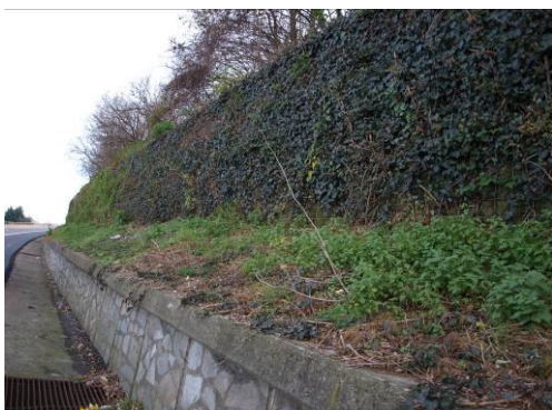
Foto 339 - Potature drastiche e piantagione di rampicanti per eliminare problemi di manutenzioni periodiche di specie arbustive si TRV (Foto Sauli – Inventario aut. Dei Trafori)muro verde settembre 2003
