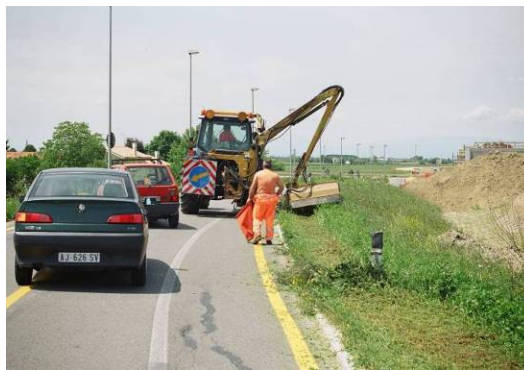
Foto 334 Idem manutenzioni con barra rotante – Foto G. Sauli 2006)
