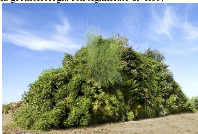
Foto 202 – Barriera antirumore vegetata ad arbusti in terrapieno compresso in struttura metallica. Campione di recente realizzazione con cura particolare per il suolo di riempimento (suolo tecnogenico) ed evidente successo dello sviluppo della vegetazione. (Foto G. Sauli)
