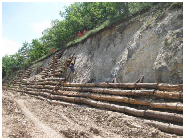
Foto 291 Nuovo tipo di palificata “loricata” con tronchi abbinati a briglie ad ombrello in costruzione (Molina Aterno (AQ) Parco Sirente e Velino – foto C. Cornellini)
