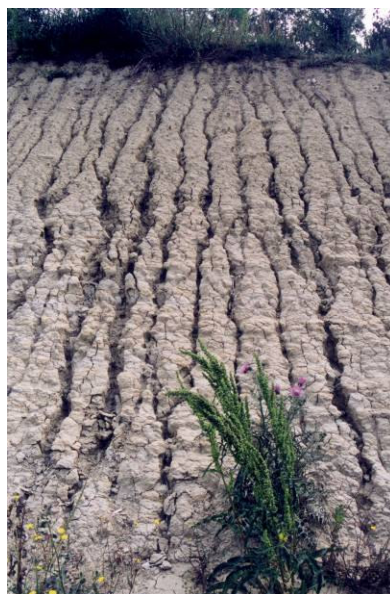
Foto 172 - Inizio di solchi di erosione su scarpate non rivegetate in trincea in litologia sciolta a matrice argillosa. (3° corsia autostrada Orte-Fiano Foto G. Sauli)
