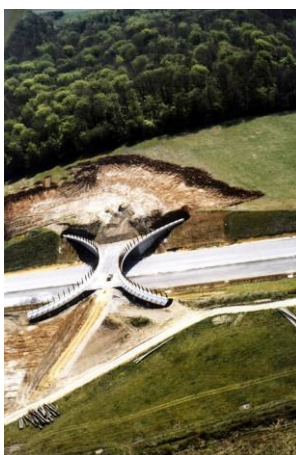
Foto 217 – Ponte per ungulati con strutture di invito ad imbuto (Lussemburgo anni '80). Foto G. Sauli
