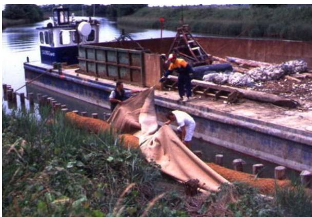
Foto 129 Consolidamento spondale di un canale perilagunare con tronchi, rulli di cocco, geotessuti e fibre miste abbinati a fascine di tamerice
